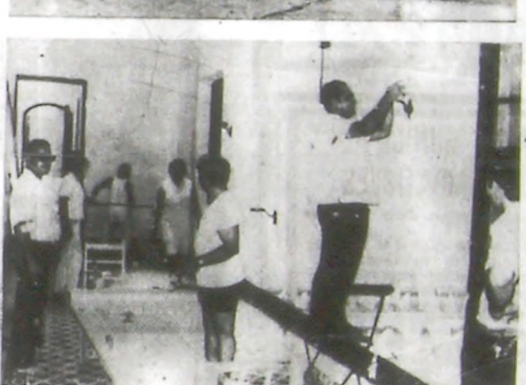
Las notas gráficas muestran a militantes comunistas de San José en los trabajos de remodelación del viejo local de la calle Colón. Obras que serán inauguradas el domingo 18.
